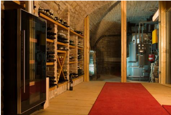
Gewölbekeller mit Technikraum
