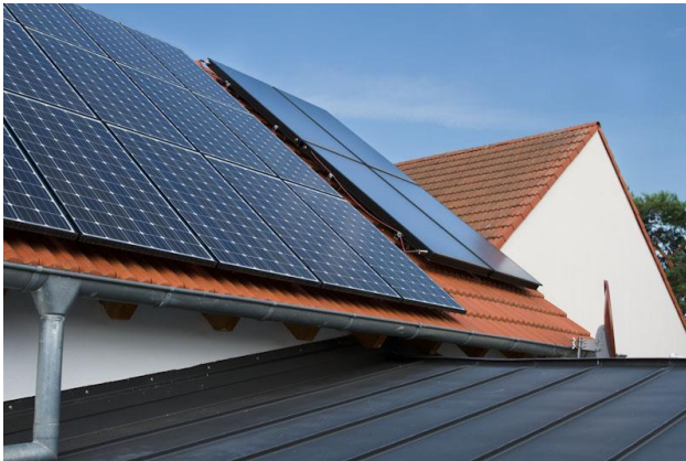
Photovoltaik und Solarthermie
