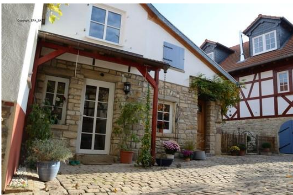
Das Büro- und Tagungsgebäude
